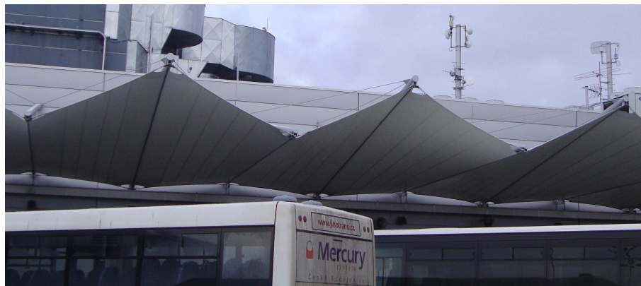
Obrázek 31: Prostorové čtyřúhelníky tvoří základ systému zastřešení autobusového nádraží v Českých Budějovicích (plochy, které je vyplňují se nazývají hyperbolické paraboloidy ). (Fotografie byla pořízena s laskavým svolením Správy Mercury centra)
