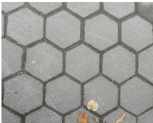
Obrázek 44: Jednoduchá dlažba – pravidelné šestiúhelníky
