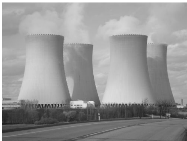
Obrázek 2.11: Chladicí věže jaderné elektrárny v Temelíně - rotační jednodílné hyperboloidy
