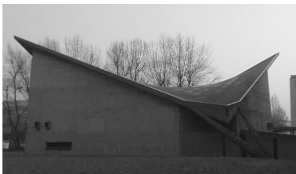
Obrázek 2.31: Zastřešení budovy hyperbolickým paraboloidem - kampus Claude Bernard University Lyon
