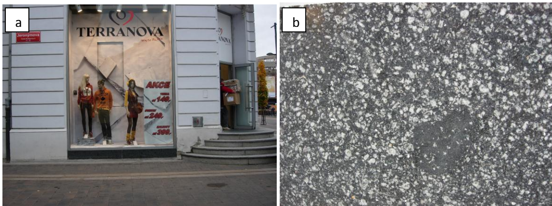
Obr. 14: Diorit a) použitý pod výlohou prodejny Terranova na rohu Lannovy třídy a Jeronýmovy ulice, b) detail tmavého dioritu s patrnými vyrostlicemi bílého plagioklasu a uzavřeninou.
