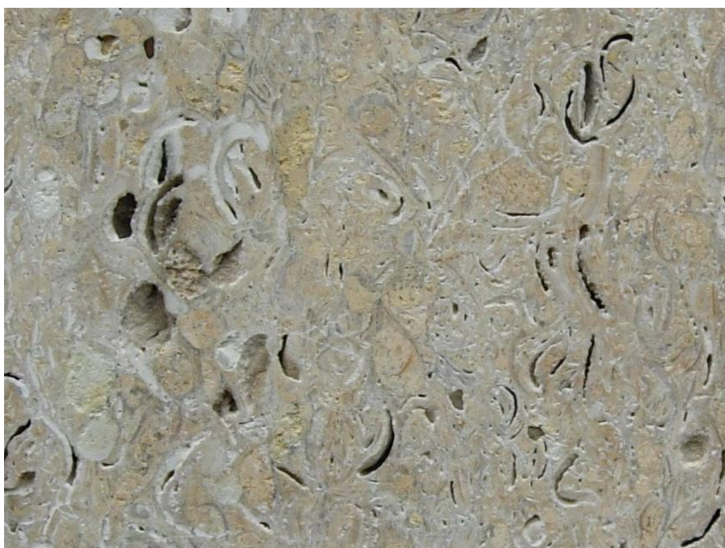
Obr. 8: Biogenní vápenec s fosiliemi
