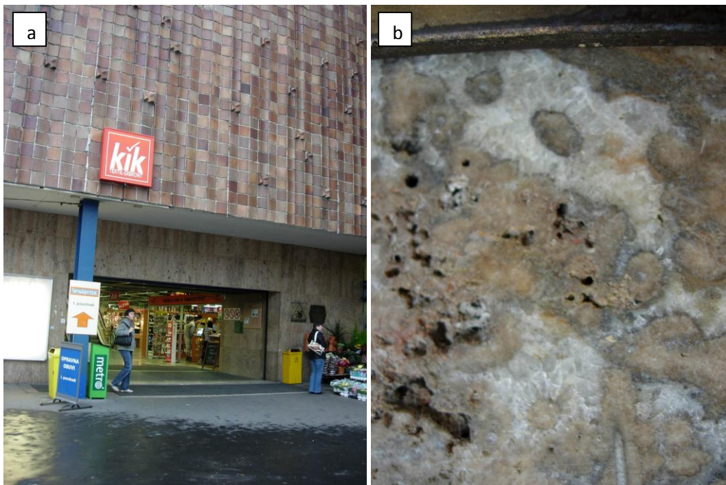
Obr. 16: Zlatý travertin a) u vstupu do OD Prior, b) detail pórovité textury vyplněné hnízdý aragonitu.
