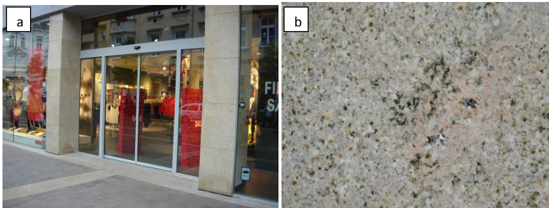
Obr. 12: Světlá jemnozrná žula a) na obkladech prodejny Vagabond, NewYorker, Kappahl, b) detail světlé žuly s částí bohatší na mírně narůžovělý draselný živec
