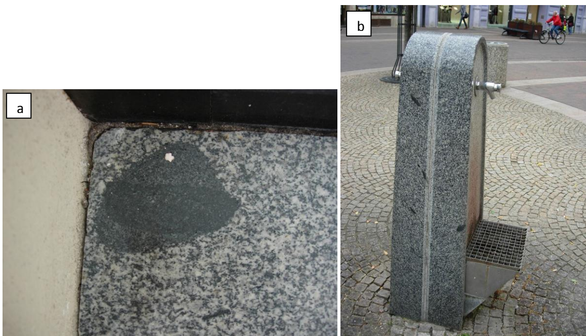
Obr. 10: Granodiorit a) na okenních parapetech papírnickví a prodejny O2 s tmavou uzavřeninou, b) na pítku na rohu Lannovy třídy a Jeronýmovy ulice.
