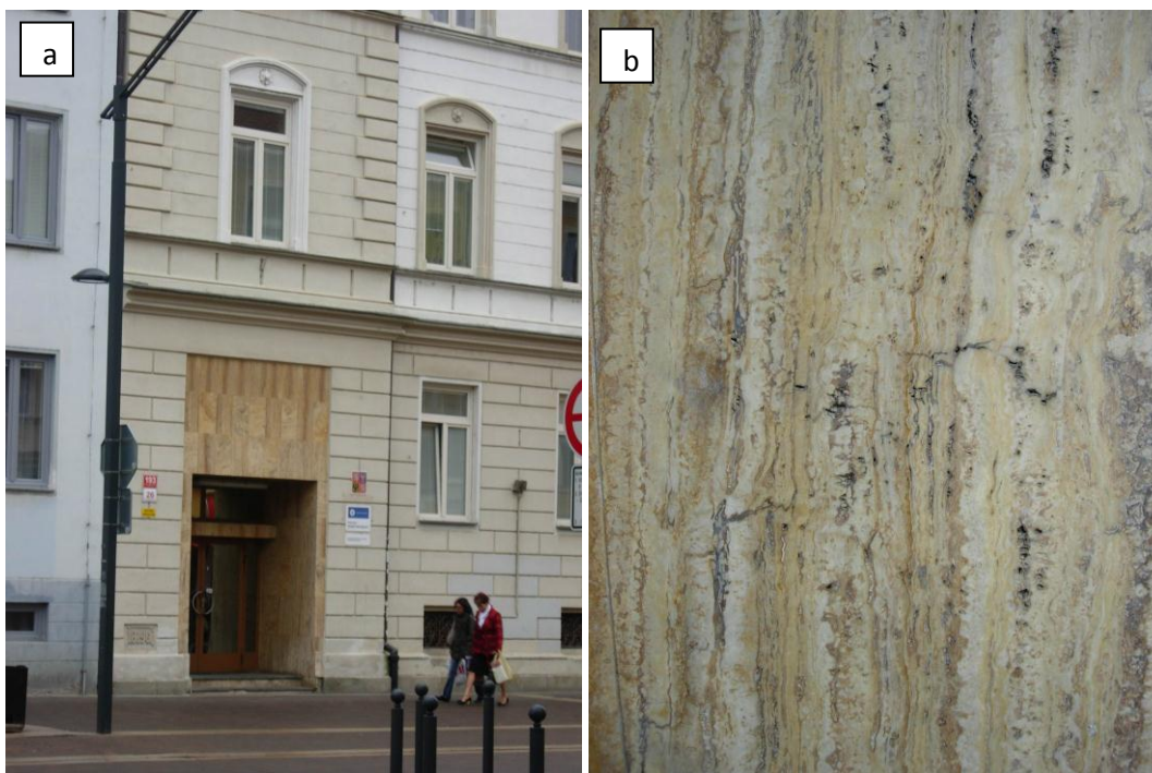
Obr. 17: Travertin a) u vstupu do budovy Policie ČR, b) detail rezavě zbarvených vrstev
