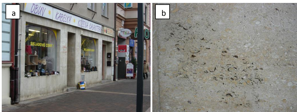
Obr. 20: a) Obklad prodejny Kožené galanterie tvořený biogenním vápencem , b) detail biogenního vápence s otisky živočišných schránek a volným prostorem po rozpuštěných schránkách.
