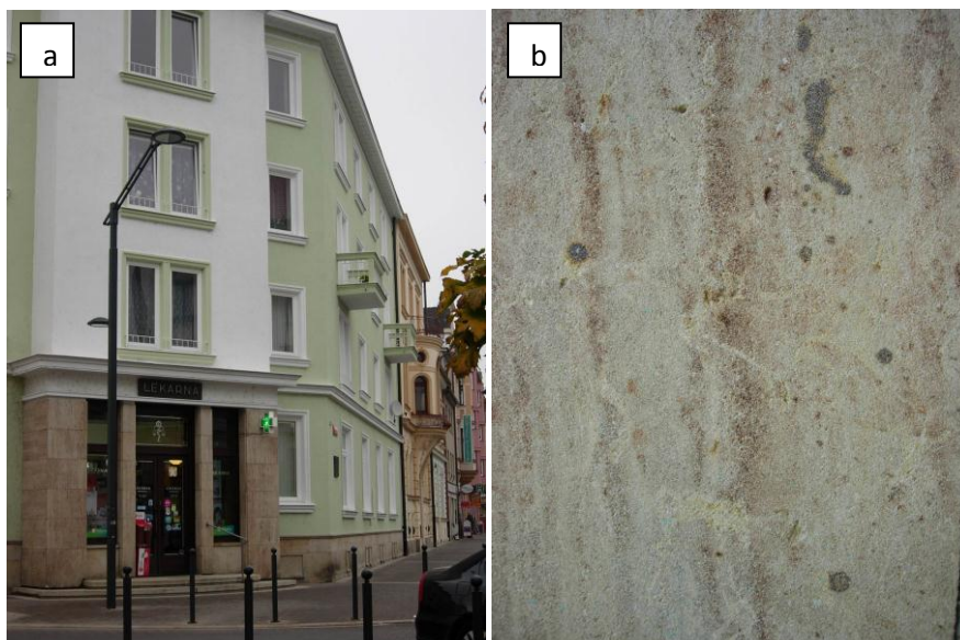
Obr. 19: Obklady z neleštěného pískovce a) u vstupu do lékárny na rohu Lannovy třídy a ulice Štítného, b) detail běžových a rezavých vrstev s drobnými železitými konkréciemi tmavé barvy.
