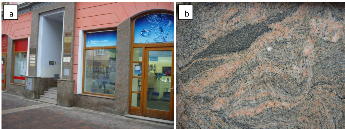
Obr. 21: a) Obklady z leštěného migmatitu použité na budově s prodejnou O2 a Poštovní spořitelnou, b) detail plasticky deformovaného migmatitu s tmavšími polohami bohatými na biotit, růžovými na draselný živec a světlými na křemen.
