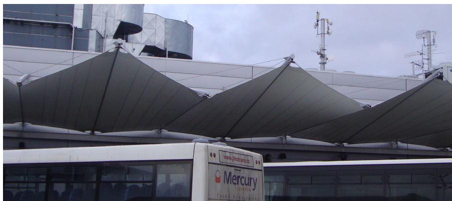
Obrázek 30: Prostorové čtyřúhelníky tvoří základ systému zastřešení autobusového nádraží v Českých Budějovicích (plochy, které je vyplňují se nazývají hyperbolické paraboloidy ). (Fotografie byla pořízena s laskavým svolením Správy Mercury centra)
