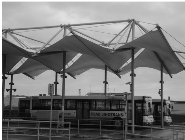
Obrázek 1.7: Hyperbolické paraboloidy jako prvky zastřešení (pořízeno s laskavým svolením správy Mercury centra)
