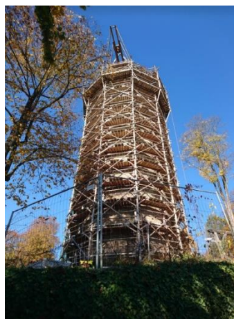
K úloze 3 – náčrtek dřevěného lešení a jeho realizace.
