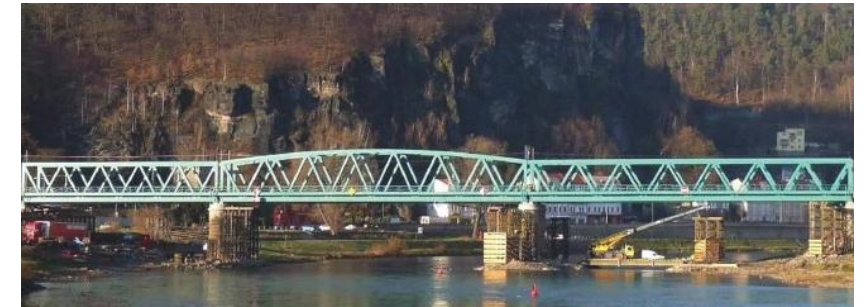
Železniční most přes Labe, Děčín
