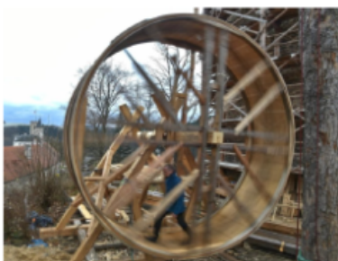
Kolo středověkého jeřábu na lidský pohon před jeho instalací na vrcholu věže Jakobínka
