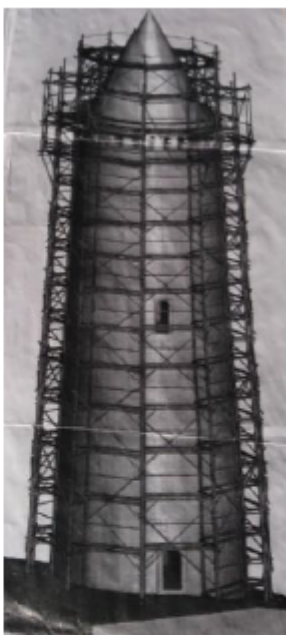
K úloze 3 – náčrtes dřevěného lešení a jeho realizace.
