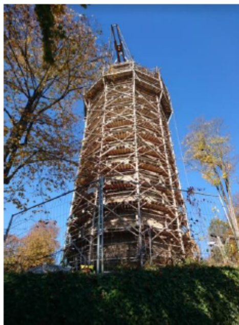
K úloze 3 – náčrtes dřevěného lešení a jeho realizace.
