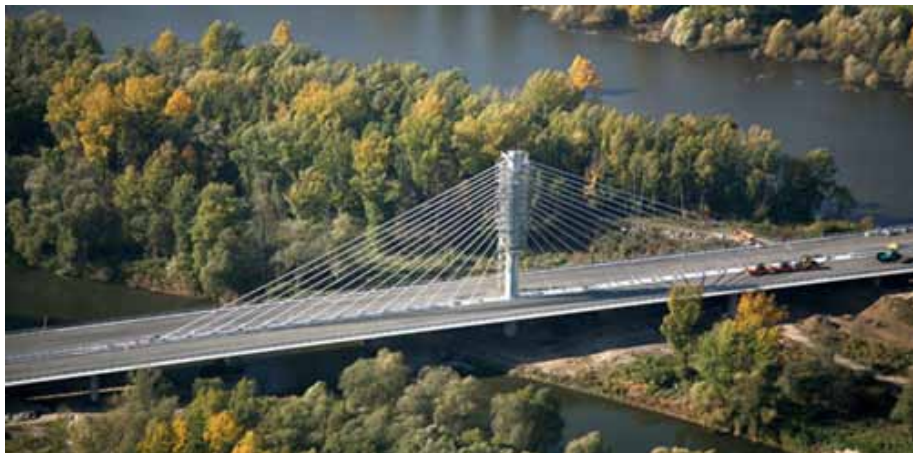
Obr. 9.1: Zavěšený most přes Odru a Antošovické jezero, převzato z [1], autoři fotografie: Tomáš Malý, Jiří Dvořák
