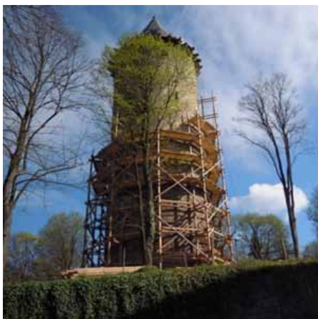
Obr. 13.1: Věž Jakobínka s rozestavěným středověkým lešením, převzato z [2] (vlevo); poháněcí šlapací kolo jeřábu před jeho instalací na věž, převzato z [3] (vpravo)
