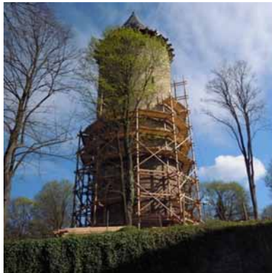
Abb. 13.1: Turm Jakobínka mit dem mittelalterlichen Baugerüst in Arbeit, übernommen von [2] (links); Tretrad als Antrieb des Kranes vor seinem Einbau zum Turm, übernommen von [3] (rechts)
