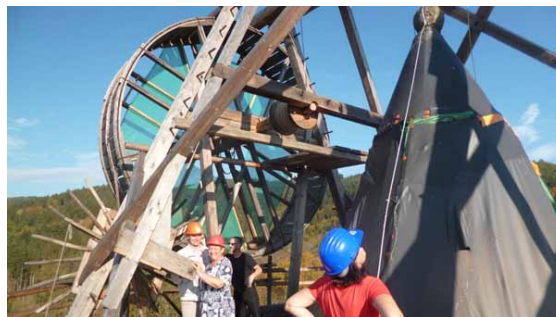
Abb. 13.2: Detail des Rades mit Winde auf der Spitze des Turmes Jakobínka bei Besichtigung, Fotografin: Hana Mahnelová
